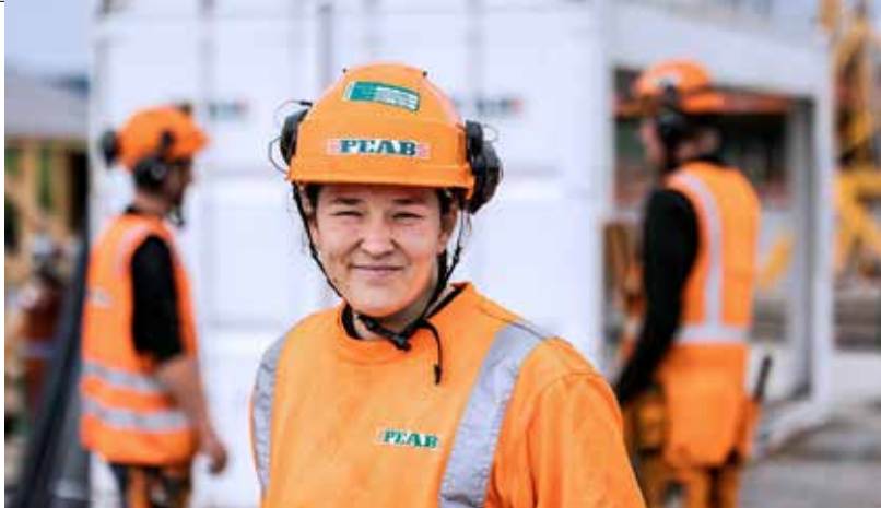
Tar gjerne tunge løft: Jernbinding er en av de nye arbeidsoppgavene for Thalie Slåtta, her på jobb i Porsgrunn. Foto: Mats Bakken
