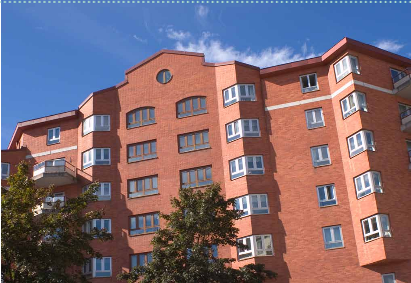
TENKER NYTT: Serafen vård- og omsorgsboende er en gigantisk boligblokk midt i Stockholm, men med 176 individuelt tilpassede boenheter for eldre med pleiebehov. Foto: Serafens äldreboende.
