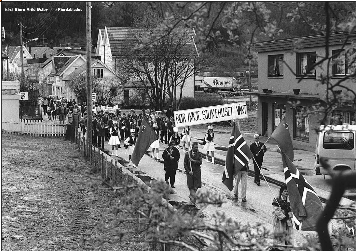
SYKEHUS: Nordfjord Sjukehus i Eid kommune ble tatt i bruk i 1936 med 42 senger. Sykehuset ble for en stor del bygget med midler gitt av den amerikanske kunstmaleren William Henry Singer jr. og kona Anna som budde i Olden. Siden har det vært mange aksjoner for å bevare lokalsykehuset på Nordfjordeid. Her fra demonstrasjonen i 1982.
